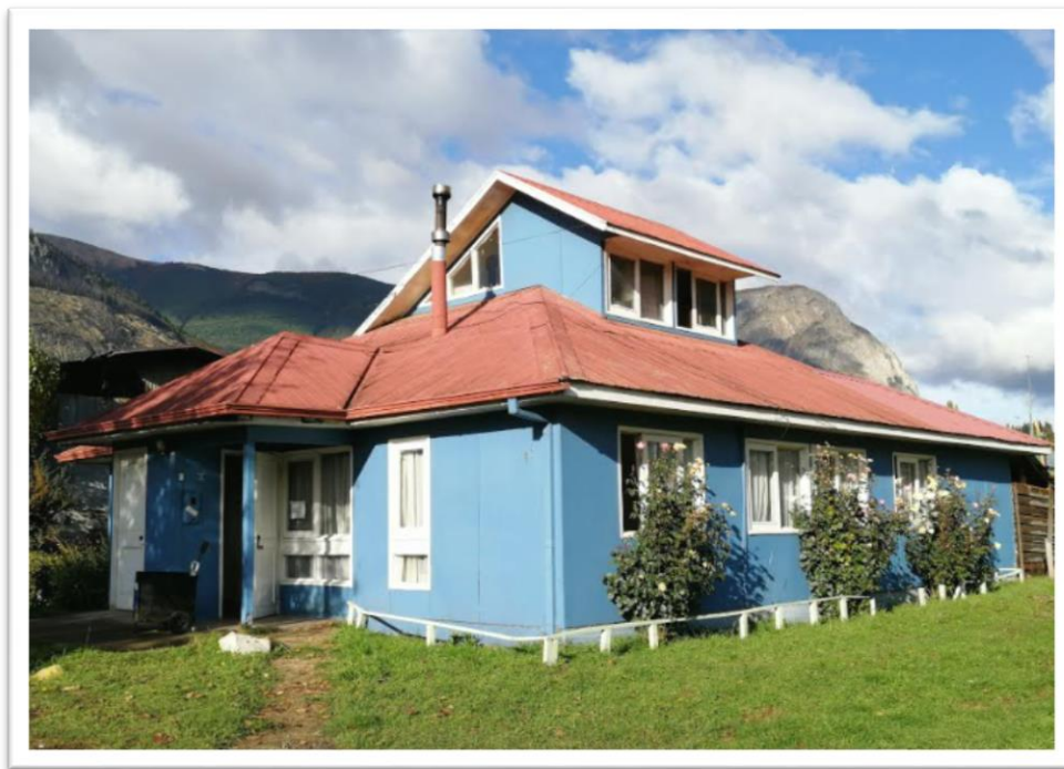
Vista exterior anexo Casa 5
